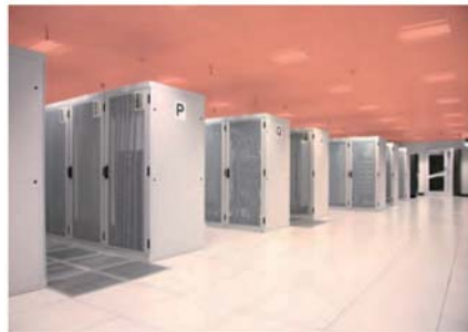
Protection de plafond en Data center
